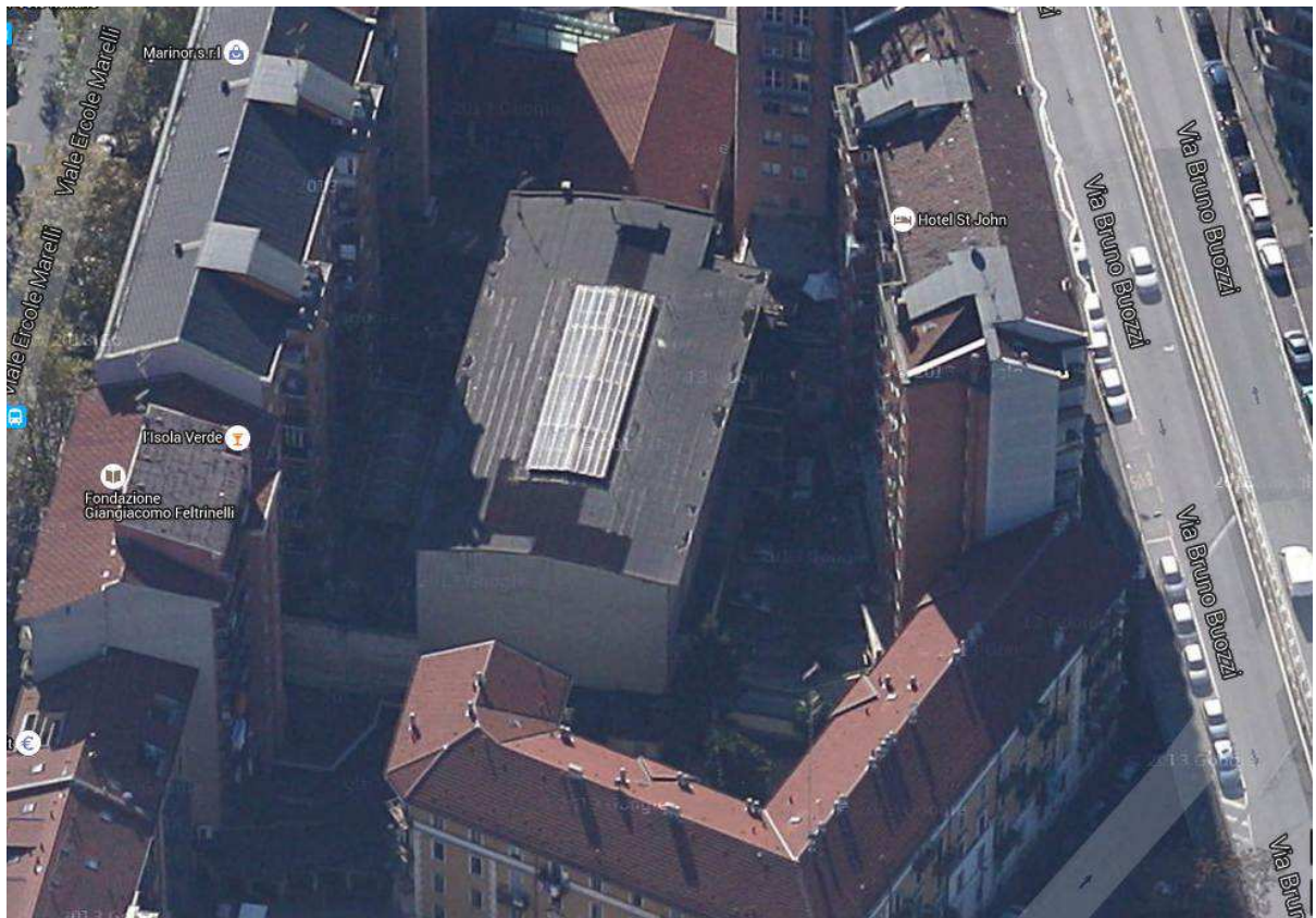
Vista aerea del cinema Apollo intercluso all'interno dell'isolato
