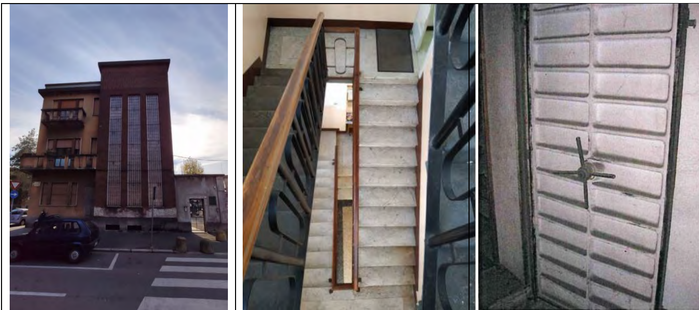
Palazzina: facciata principale su strada, corpo scale e porta di accesso al rifugio antiaereo (Fonti: www.benitutelati.it e sopralluogo).
