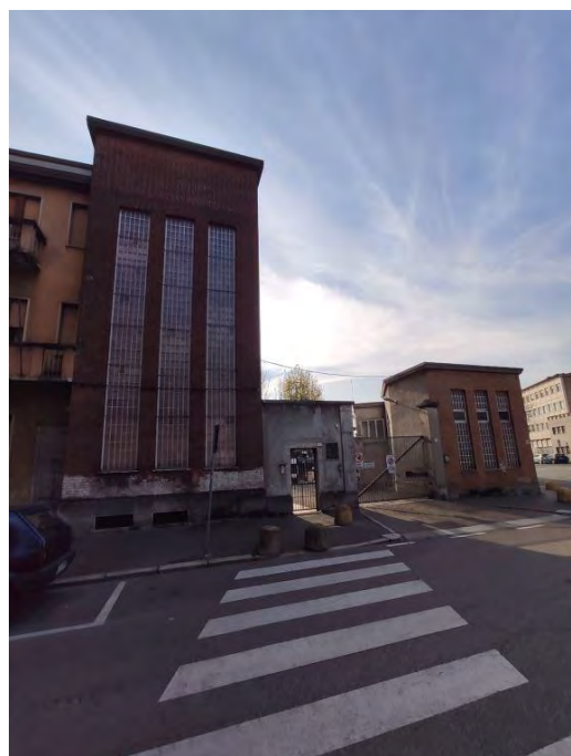
Vista dell'ingresso al complesso verso via Rovani (palazzina a sinistra e edificio dell'acquedotto a destra). (Fonte: www.benitutelati.it ).
