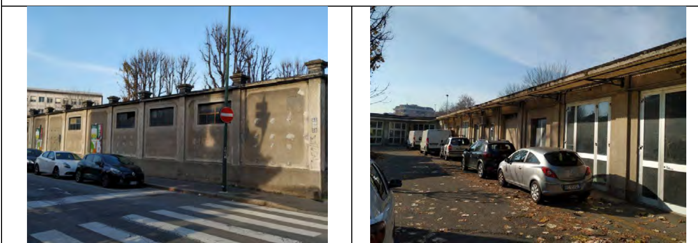
Fronte verso via Matteotti e prospetto verso la corte interna del fabbricato a un piano fuori terra ( www.benitutelati.it ).
