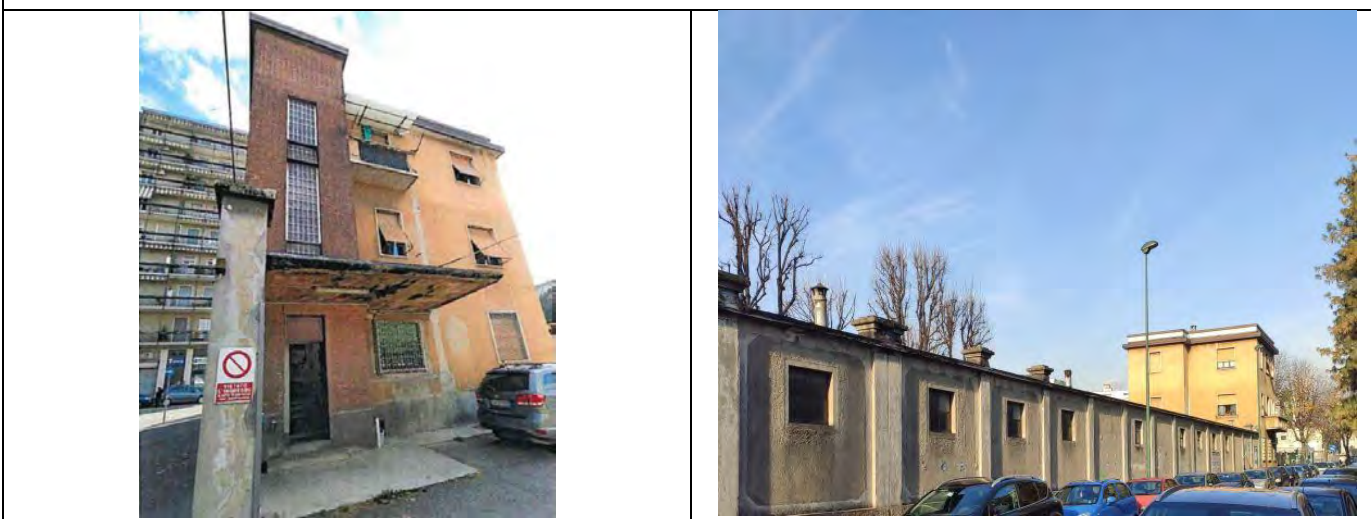
Fronte della palazzina rivolto verso il cortile e prospetto lungo la via D. Chiesa (Fonti: www.benitutelati.it e sopralluogo).
