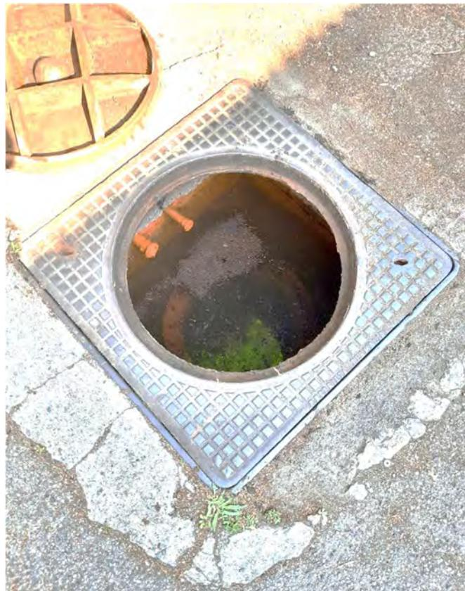
Foto 2 – tombino imbocco serbatoio benzina (visibile la presenza di acqua)
