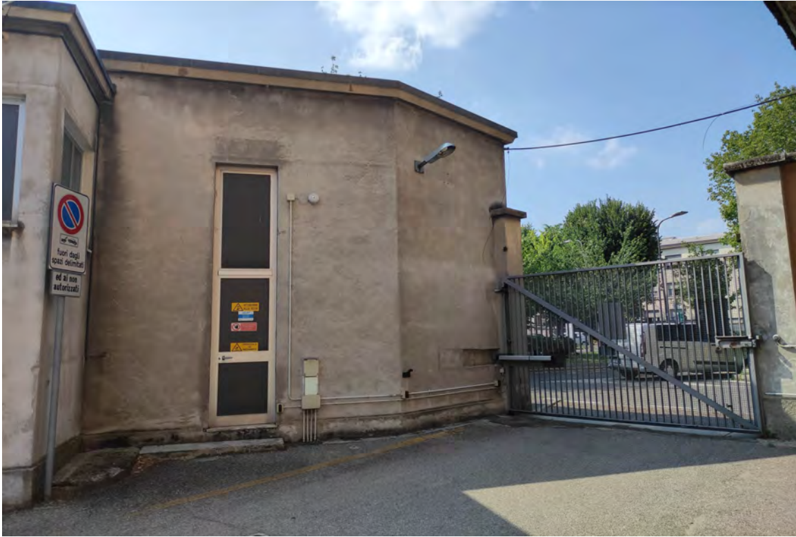
Foto n° B9 - Fabbricato CAP
