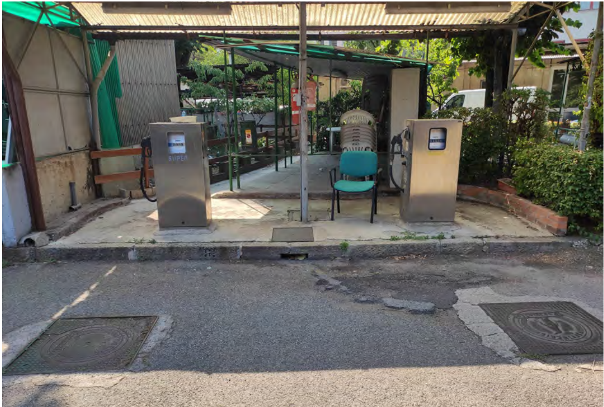
Foto n° F9 ex impianto distributore carburanti
