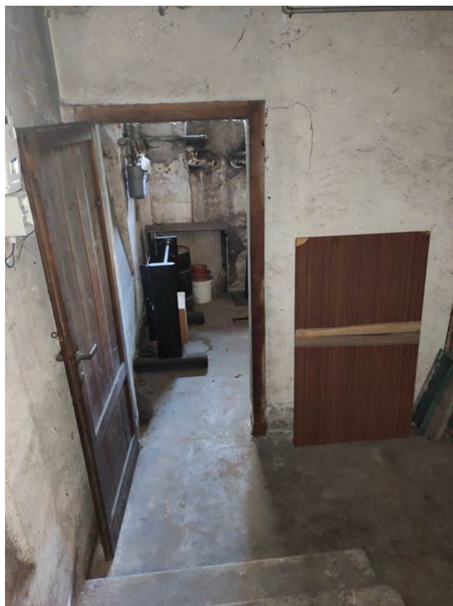
Foto n° E2 - Accesso interrato
