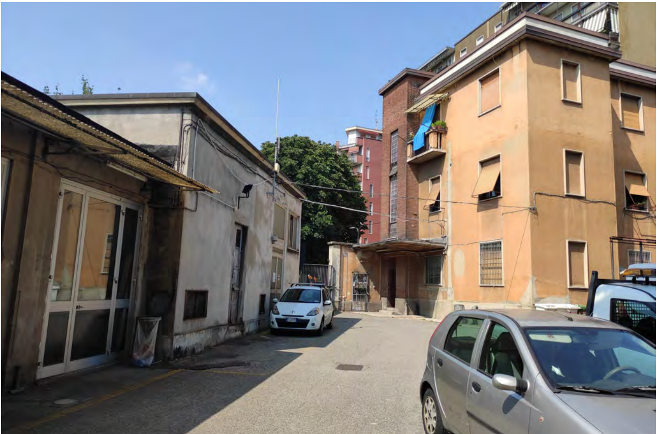
Foto n° B7 - Fabbricato CAP - Palazzina abitativa
