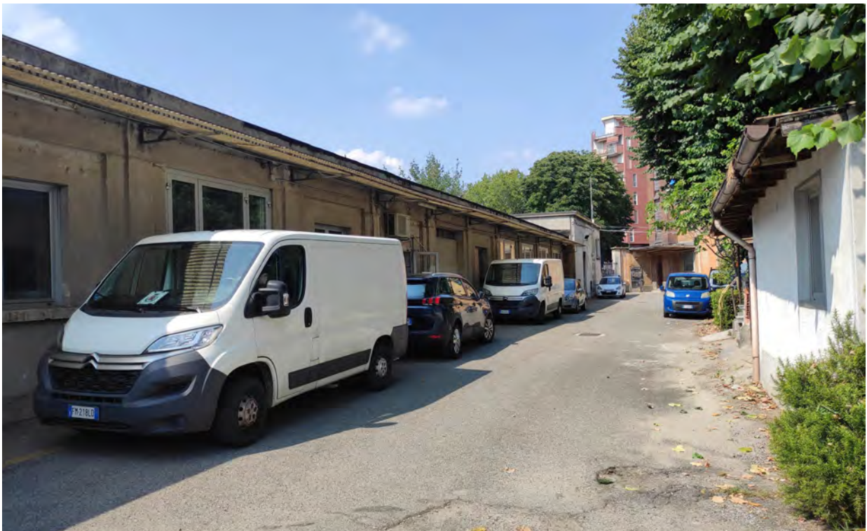
Foto n° B6 - Ingresso magazzini produttivi
