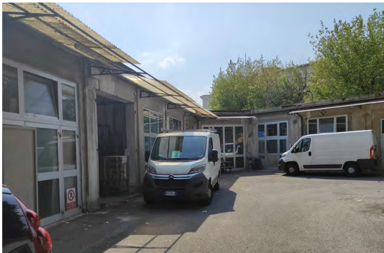
Foto n° B2 - Ingresso magazzini produttivi
