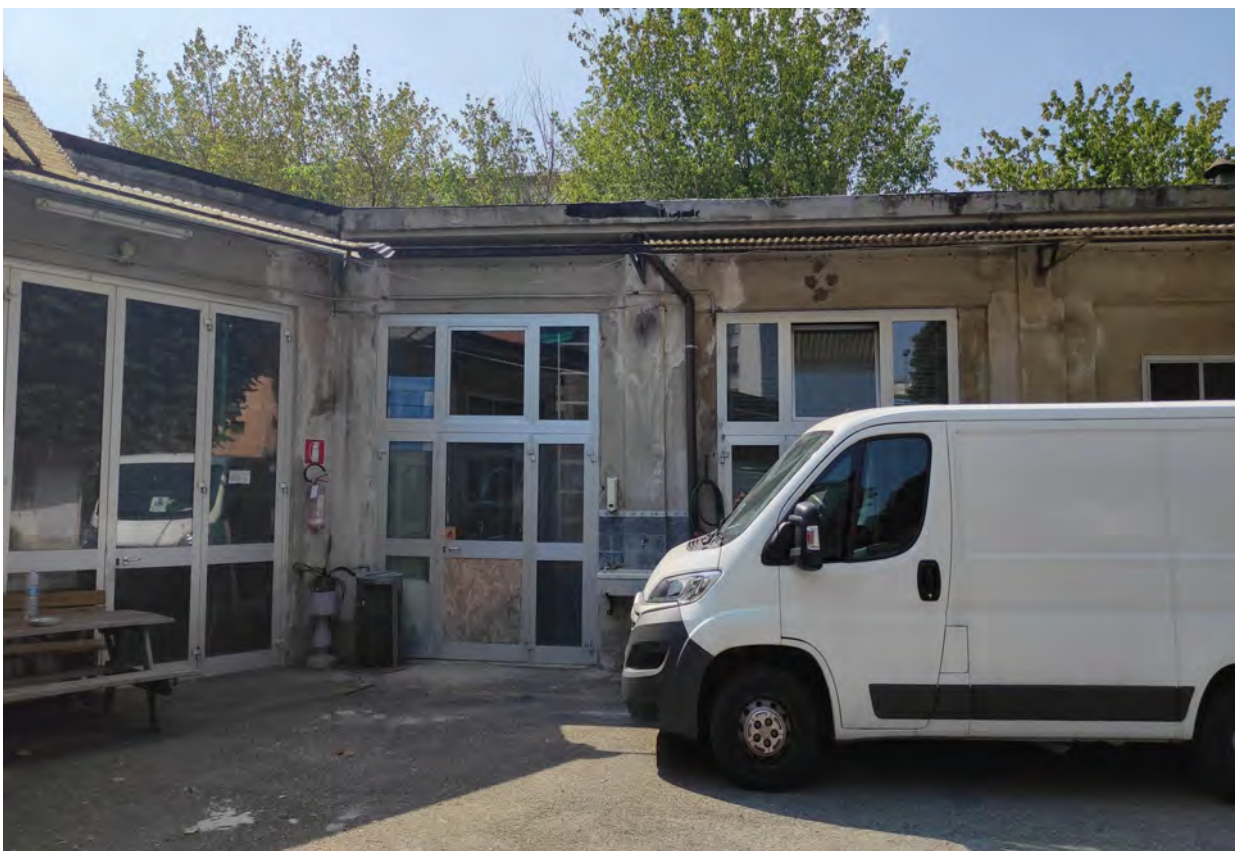
Foto n° B4 - Ingresso magazzini produttivi
