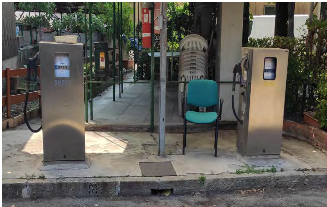
Foto n° F10 ex impianto distributore carburanti
