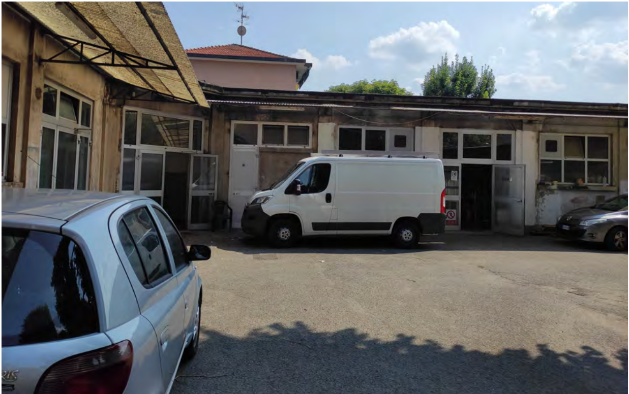
Foto n° B3 - Ingresso magazzini produttivi
