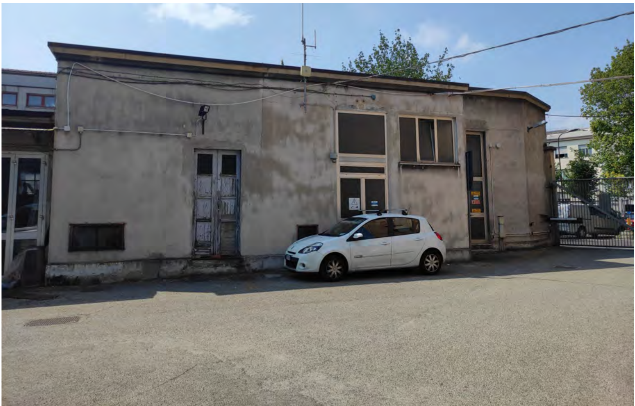
Foto n° B8 - Fabbricato CAP
