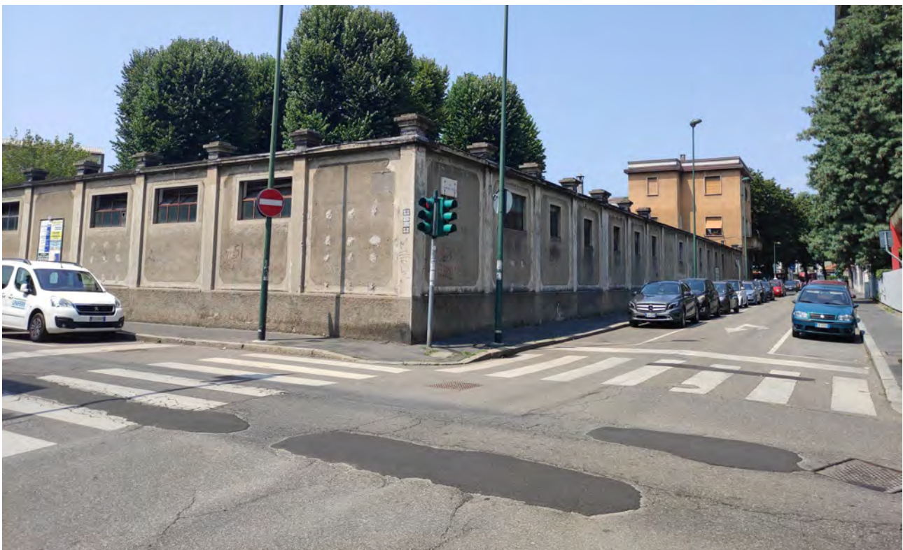
Foto n° A8 - Vista da incrocio Via F.lli Bandiera Via Damiano Chiesa
