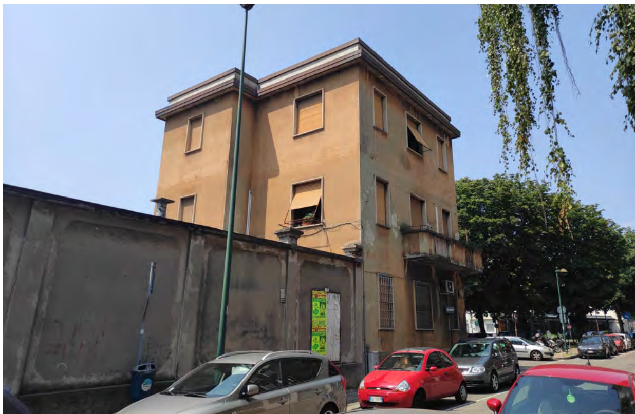
Foto n° A11 - Vista da Via Damiano Chiesa - palazzina abitativa
