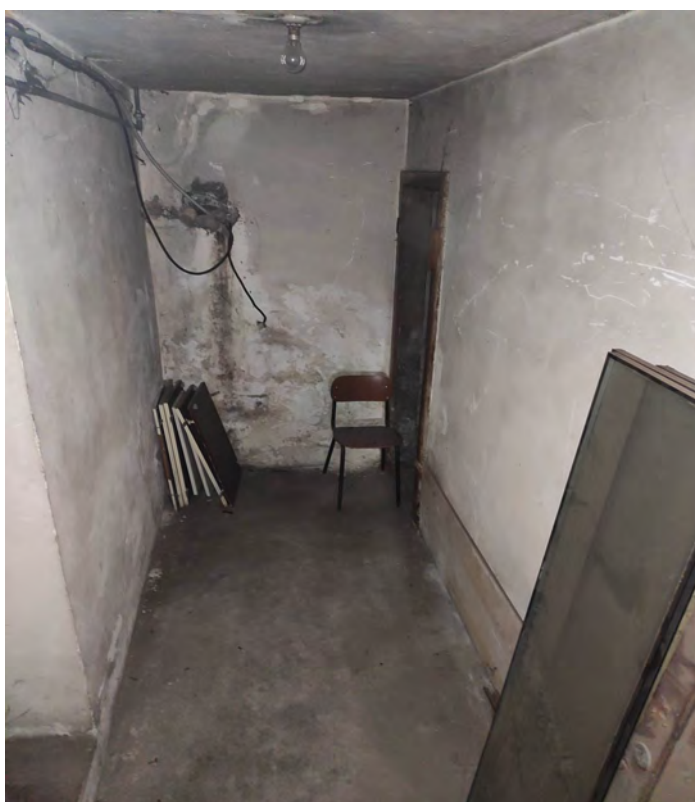
Foto n° E3 - Interrato
