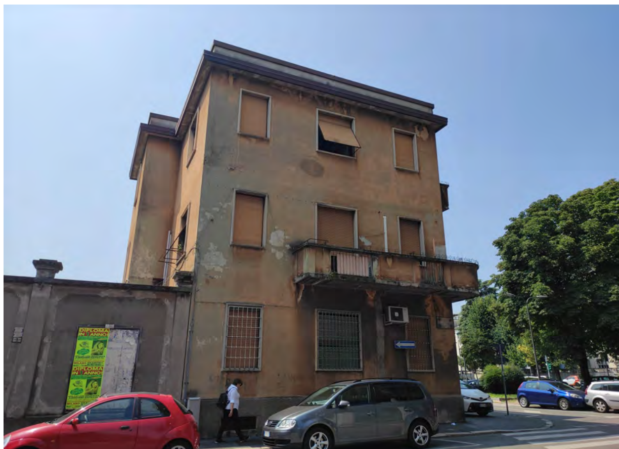
Foto n° A12 - Vista da Via Damiano Chiesa - angolo Via Rovani
