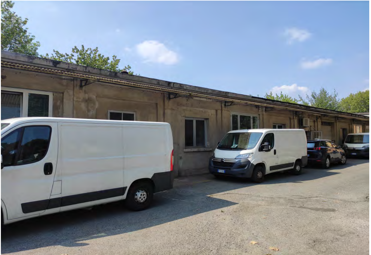
Foto n° B5 - Ingresso magazzini produttivi
