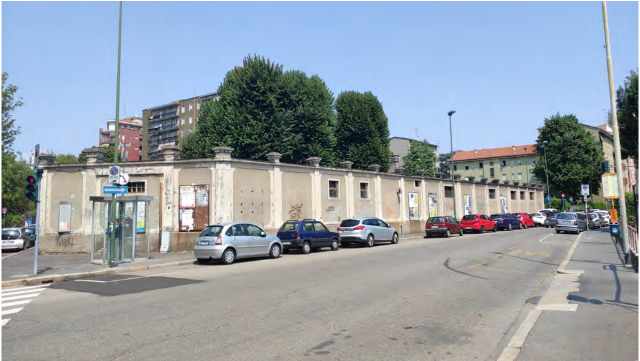
Foto A7 - Vista da Via F.lli Bandiera
