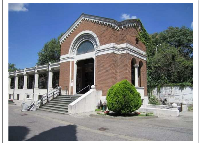
Corpo ingresso galleria
