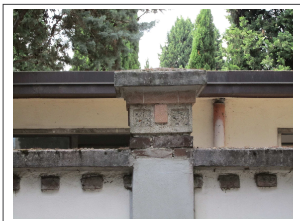
Particolare recinzione lato ingresso
