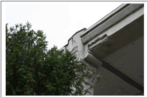
Particolare gronda gallerie
