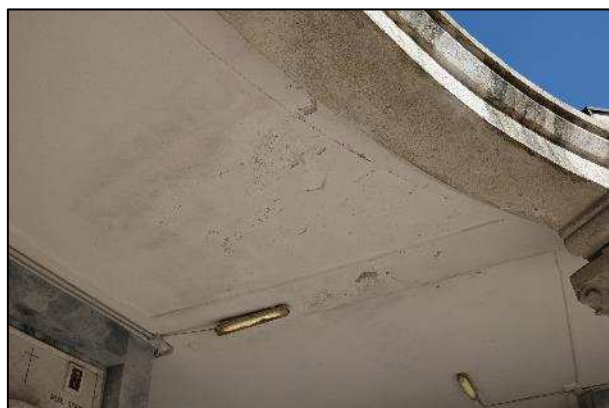
Particolare soffitto gallerie
