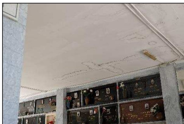
Particolare soffitto gallerie
