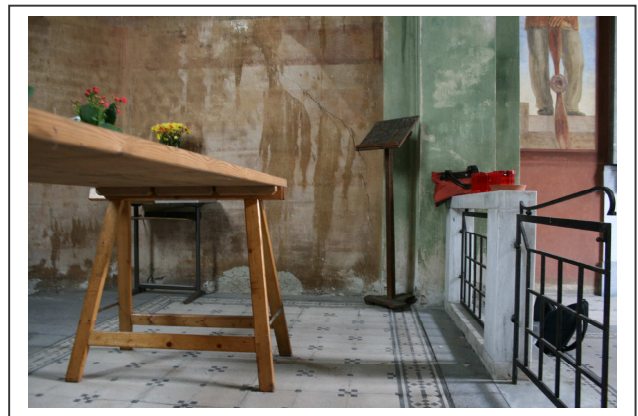
Particolare interno Cappella per il Culto
