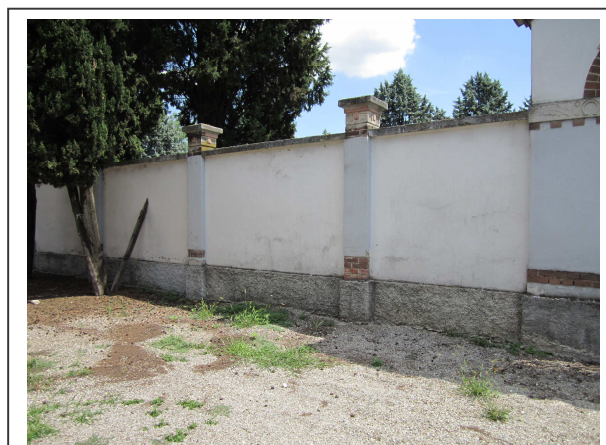
Recinzione lato ingresso
