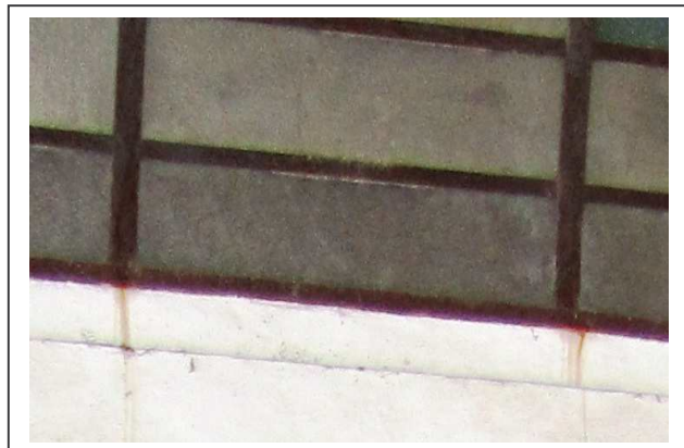
Particolare volta a botte in vetro corpo ingresso gallerie
