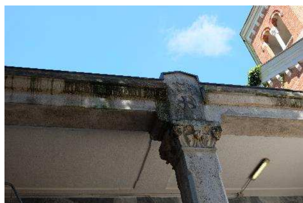
Particolare gronda gallerie
