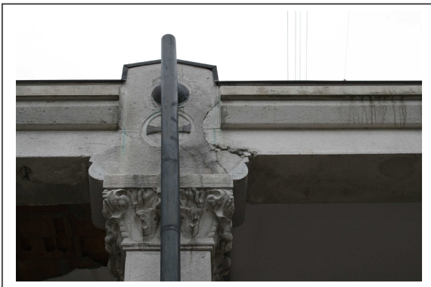
Particolare gronda gallerie
