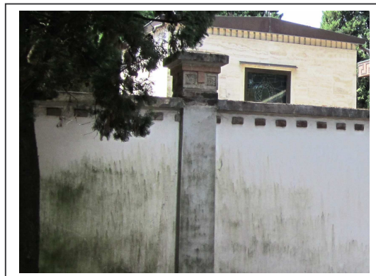
Particolare recinzione lato esterno
