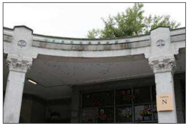
Particolare gronda gallerie
