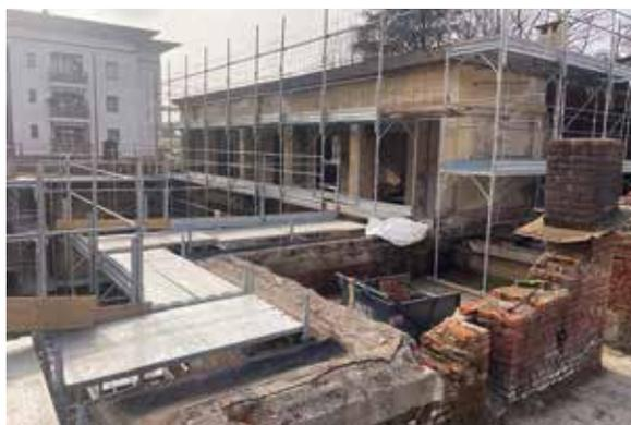
Le lavorazioni relative al miglioramento sismico hanno raggiunto stati di avanzamento maggiori rispetto a quanto previsto, non solo nelle demolizioni, ma anche nella fase di ricostruzione e formazione di armature complesse di pilastri e travature.
