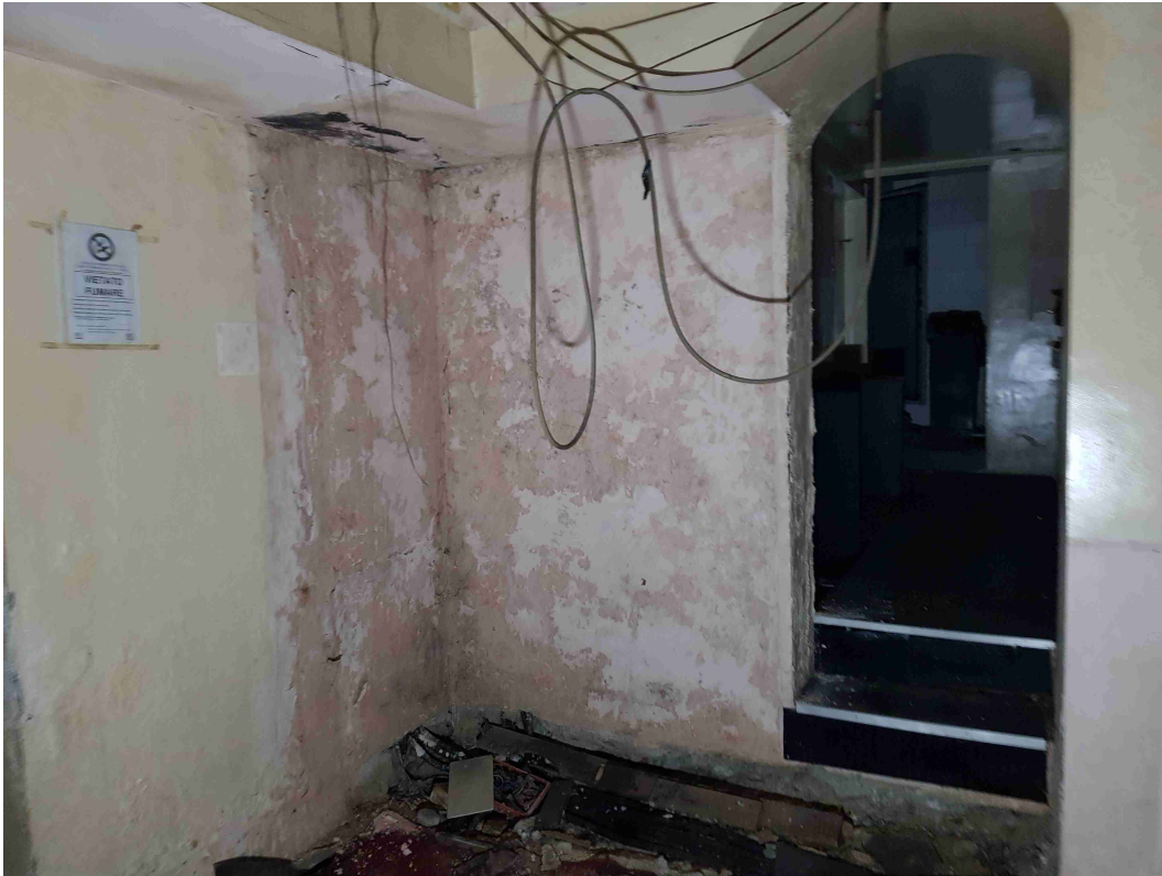
foto n.13 – particolare locale laterale
