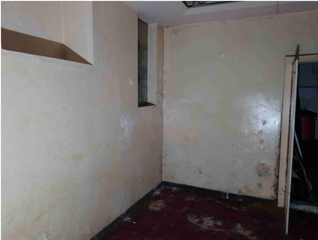
foto n.11 – particolare locale laterale
