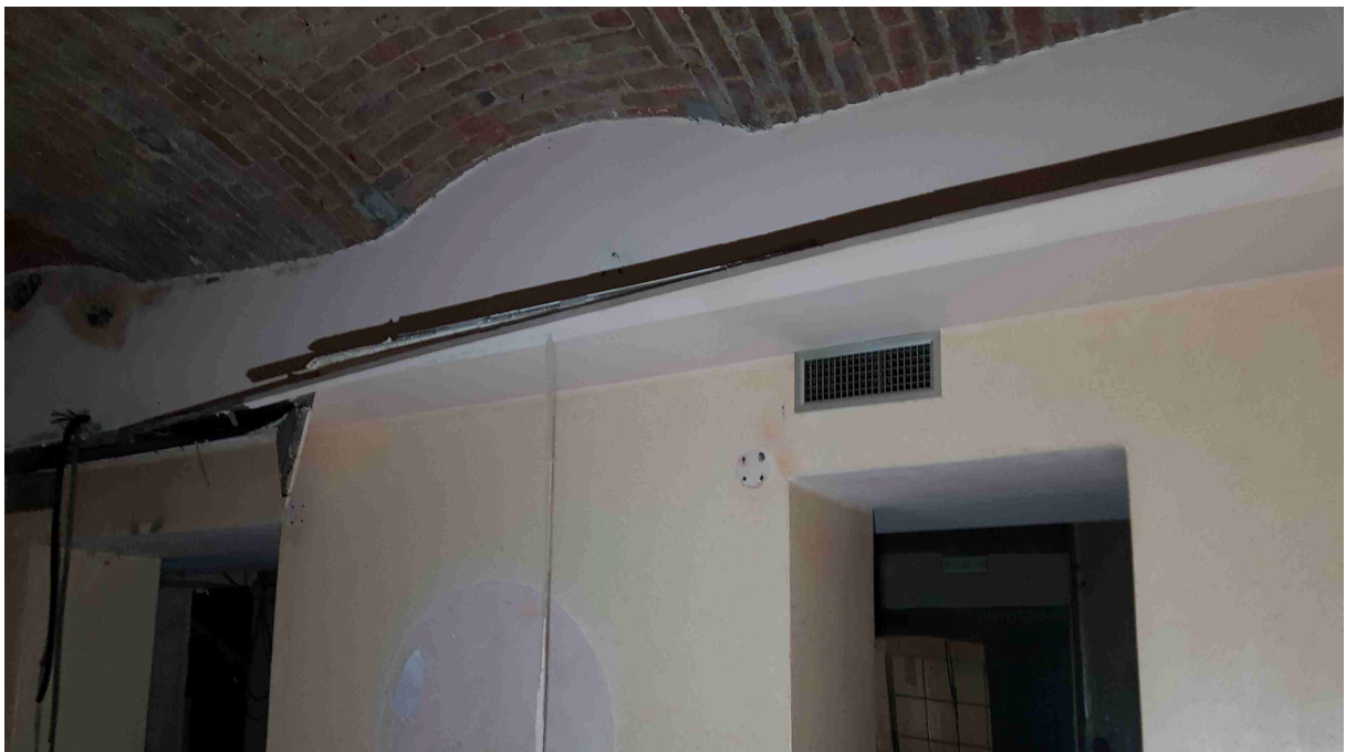
foto n.10 – vista locale principale
