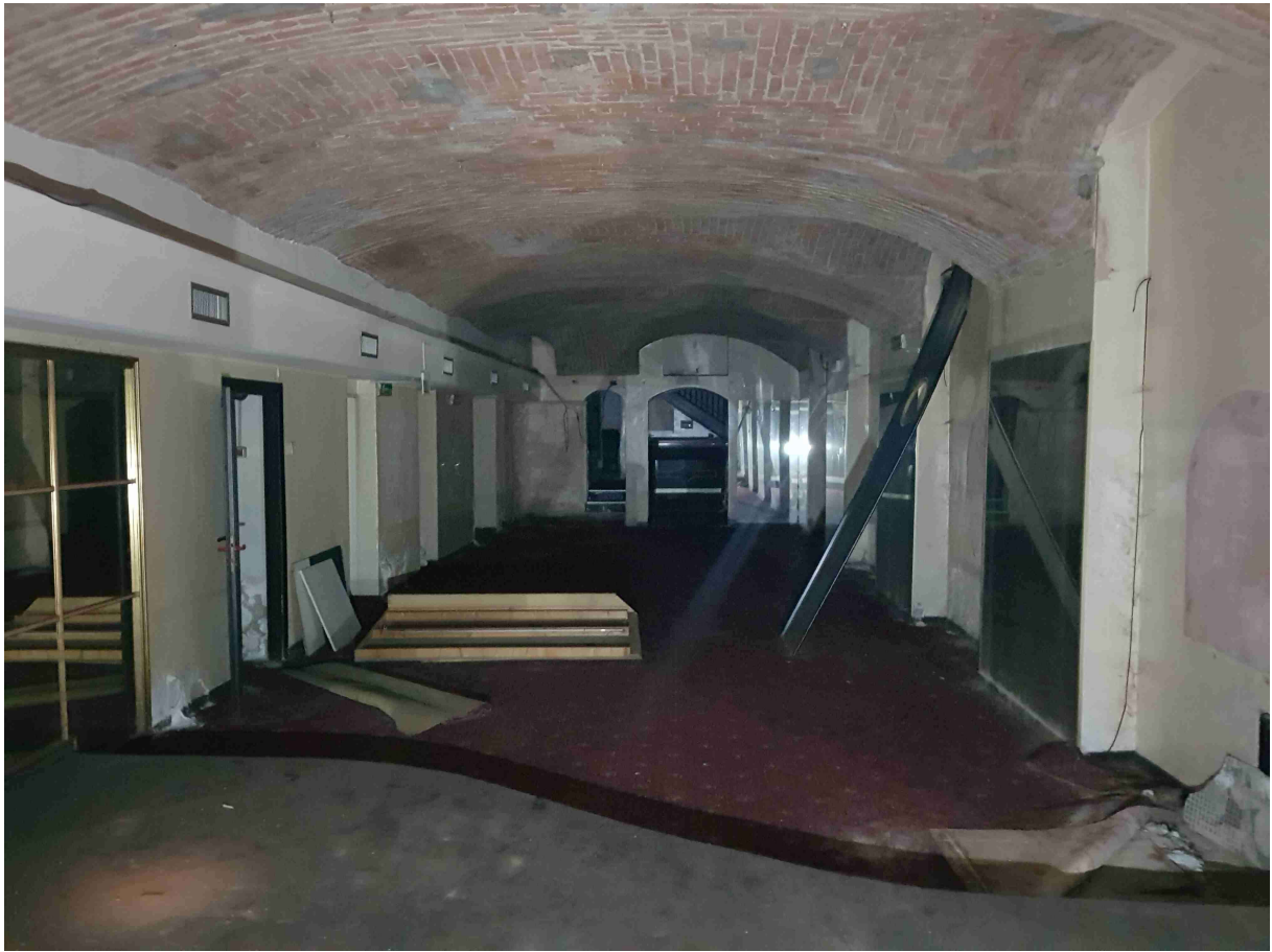
foto n.9 – vista locale principale
