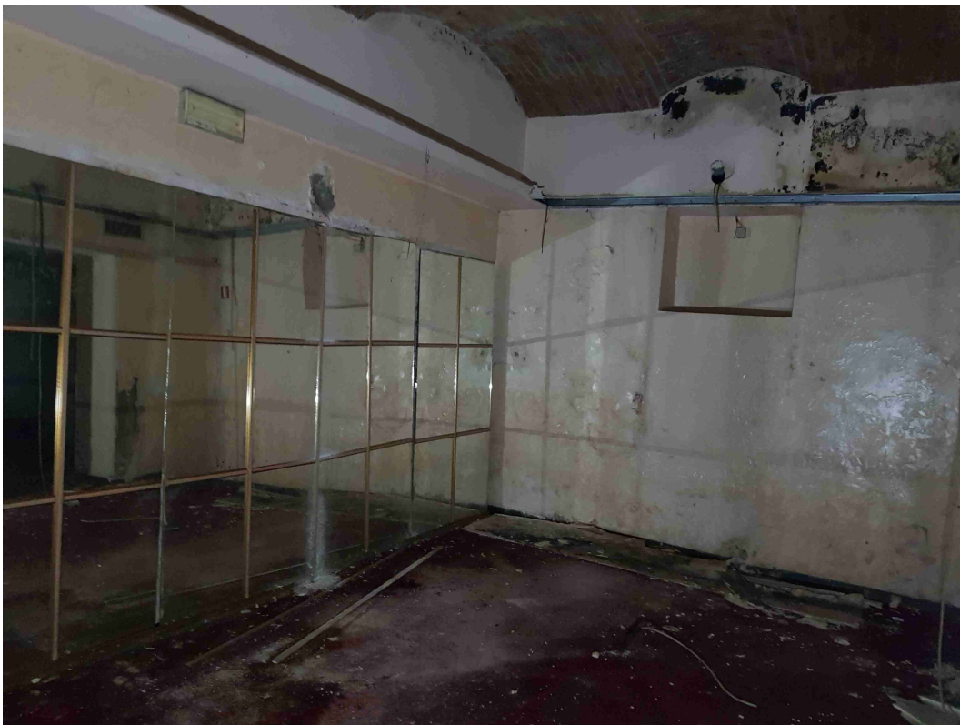
foto n.12 – particolare locale laterale
